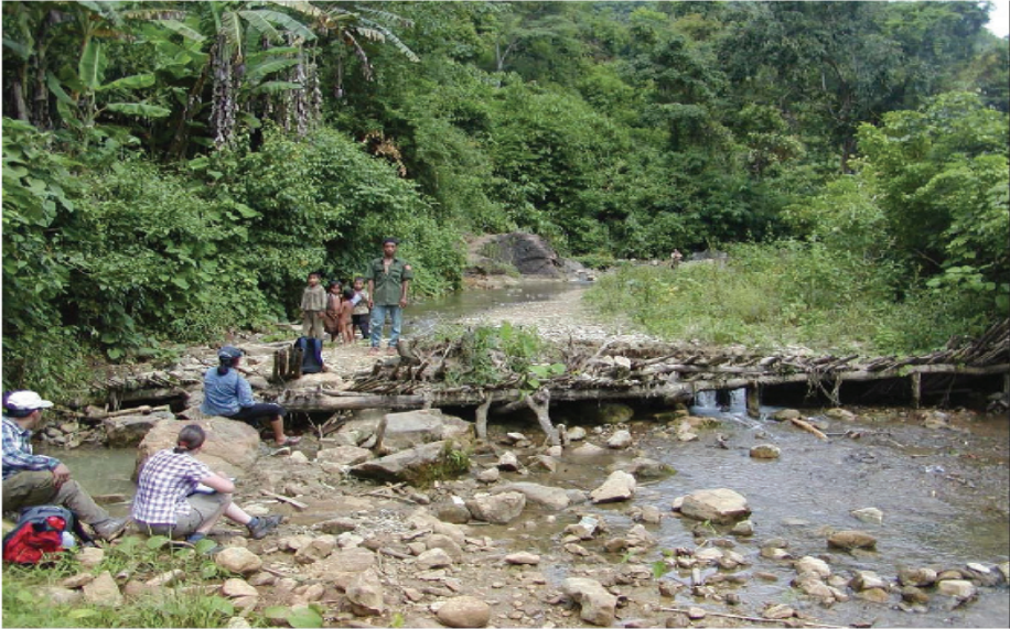
ຮູບພາບ 25.3. ຝາຍທ່ອນໄມ້ເພື່ອແຈກນ້ຳເຂົ້ານາ.
