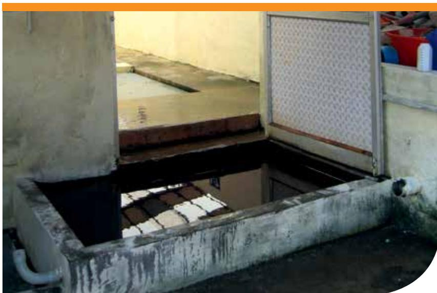
**Gambar 5.** Pintu akses ke fasilitas pendederan harus dilengkapi dengan fasilitas cuci kaki dan cuci tangan—fasilitas cuci kaki ini telah dirancang untuk mencegah staf atau pengunjung melangkahi atau memutari fasilitas tersebut (Foto: M. Rimmer)
